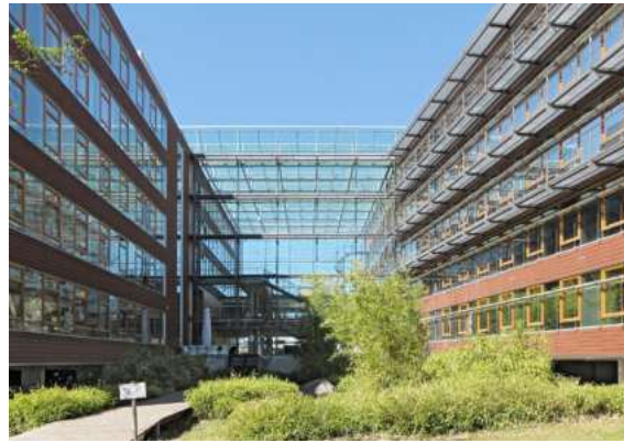
In begrünten Innenhöfen oder mehrseitig umschlossenen Gebäudebereichen erhöht sich das Kollisionsrisiko an Glasflächen. Vegetation zieht Vögel beim Flug über das Häusermeer an. Der Wegflug im steilen Winkel kann hingegen schwierig werden.
