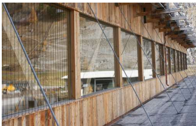
Nach wiederholtem Vogelanzprall an den spiegelnden Fenstern einer Werkhalle in S-charnf wurden nachträglich im Abstand von 8–10 cm schwarze Nylo-schnüre gespannt. Im Anschluss an die Nachrüstung wurden keine Vogelkollisionen mehr dokumentiert.
