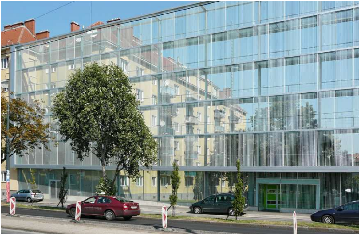
Die dreidimensionale Struktur der Lärmschutzwand von Treusch architecture am Theodor-Körner-Hof in Wien wird durch das verwendete Vogelschutzmuster bewusst optisch verstärkt.
