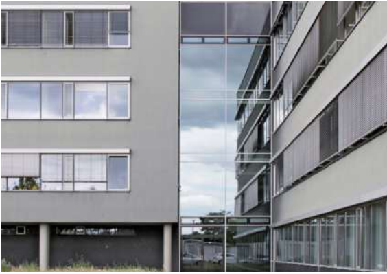
Lange Fensterbänder und spiegelnde Glasflächen werden von Vögeln als grosszügige Durchflugsmöglichkeit durch die Gebäudestruktur wahrgenommen. Die einzelnen Unterteilungen der Glasflächen haben dabei keinen kollisionsmindernden Einfluss.
