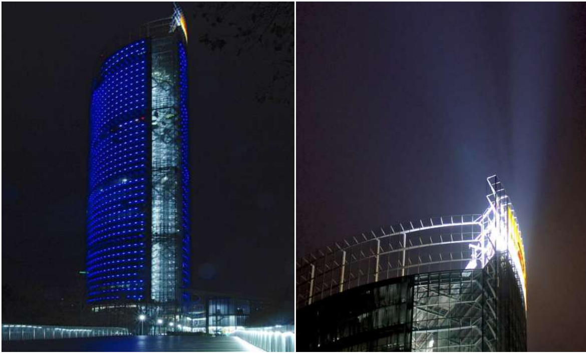
Effektbeleuchtung hinter der äusseren Glasfassade und angestrahlte Firmenlogos auf dem Dach locken am Bonner Post Tower Zugvögel ins Verderben. Solche exponiert leuchtenden Werbeflächen, Baukräne, Flugsicherheitsbeleuchtung und andere Lichtquellen in grösserer Höhe befinden sich in der Flugbahn von Zugvögeln und besitzen ein bisher oft verkanntes Gefahrenpotenzial.
