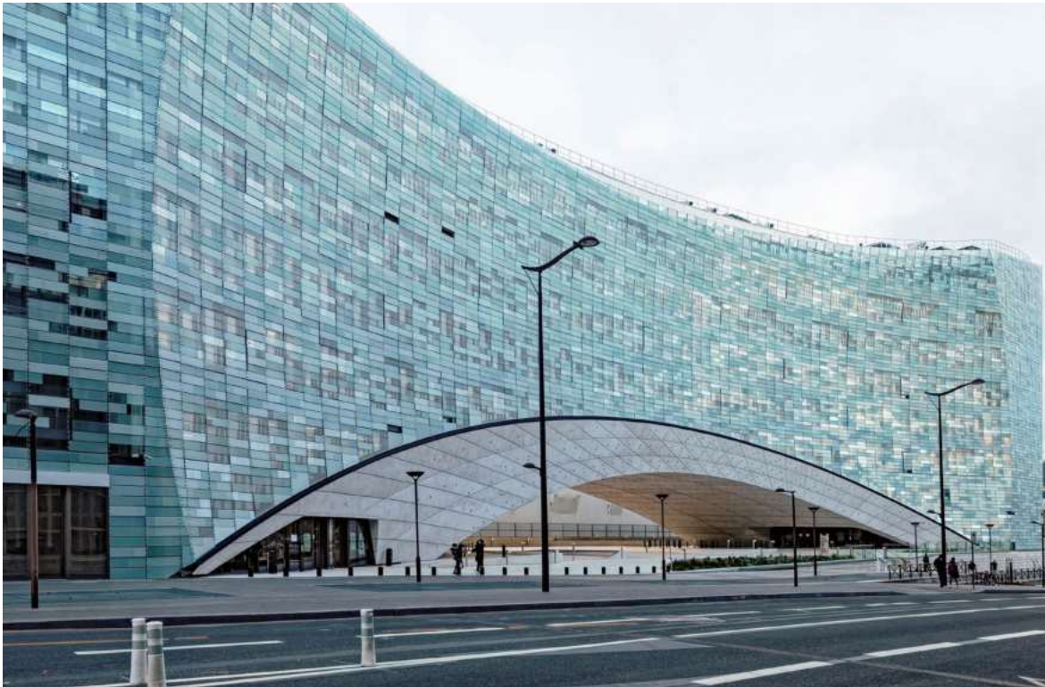
Die Fassade des Le Monde Headquarters von Snøhetta in Paris, besteht aus mehr als 20 000 Glaselementen. Sie variieren in Struktur und Transparenz und sind so angeordnet, dass sie das Licht in den Büros und den Blick nach aussen an den richtigen Positionen maximieren.
