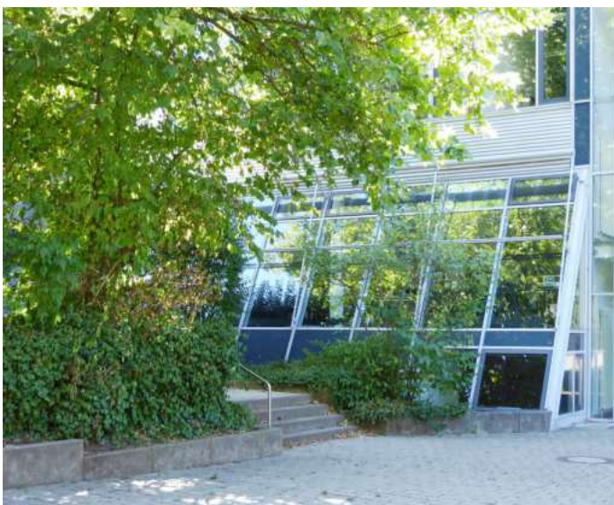
Die Spiegelungen an dieser schrägen Glasfront eines Schulgebäudes sind ebenso klar wie an einer senkrechten Scheibe und bergen somit ein hohes Kollisionsrisiko.
