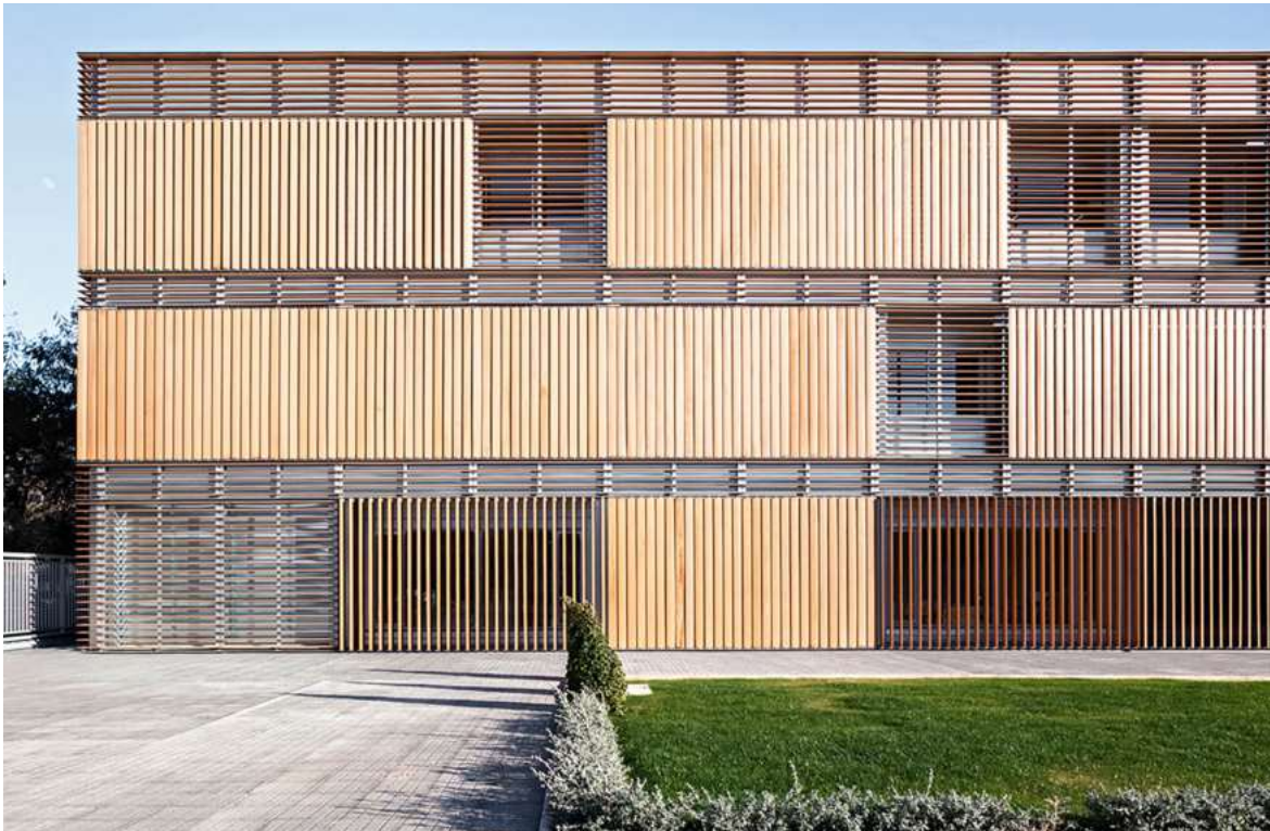
Im Westblock des Centre d'Idiomes de la Universitat de València des Architekturbüros Arkitera SLP bestimmt die Kombination von feststehenden und beweglichen Sonnenschutz-Lamellen die Fassadenstruktur.
