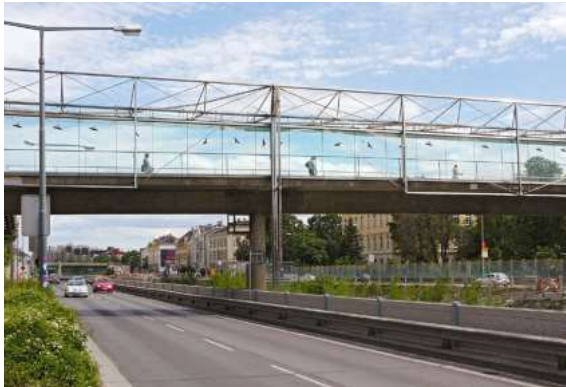
Gläserner Windschutz an Brücken und verglaste Verbindungsgänge gehören zu den augenfälligsten Vogelfallen. vielerorts sieht man aufgeklebte Greifvogelsilhouetten. Diese sind zwar unwirksam, bestätigen aber, dass es hier zu Anflügen kommt.
