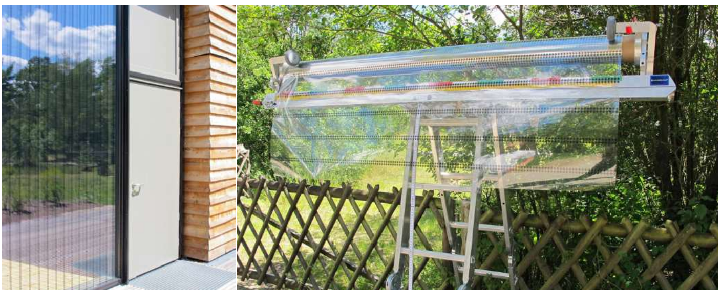
Bedruckte Folien werden vollflächig aufs Glas aufgebracht.
