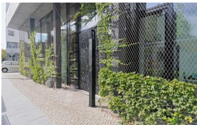
Stahlnetze, wie sie häufig zur Gebäudebegrünung genutzt werden, können bei richtiger Seilstärke auch dem Vogelschutz dienen. Bei dem Entwurf des PHED Passivhauses von scarchtitekten joerg springer/robert mieth in Berlin wurde diese Form der Fassadengestaltung von Anfang an eingeplant. Je nach Fassadenbeschaffenheit können entsprechende Netze aber auch nachträglich installiert werden.
