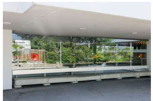
Obwohl das Gebäude mehrere Meter auskragt, sind an den Fenstern deutliche Spiegelungen zu erkennen. Schattenwurf eliminiert die Spiegelungen nicht.
