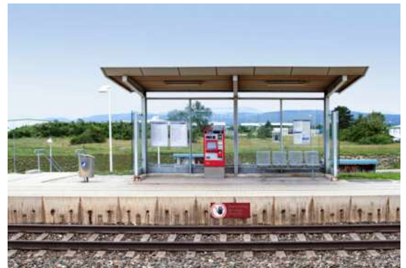
Fahrgastunterstände werden vielfach in Glas ausgeführt, ohne an Sicherungsmassnahmen für Vögel zu denken.
