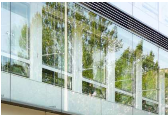
Auch auf vorgehängten Fassaden können realistische Spiegelungen entstehen.
