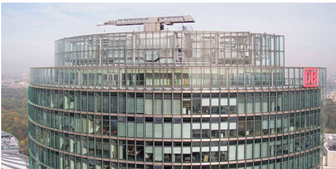
Meterhohe gläserne Attika auf einem Hochhaus: Vögel kollidieren hier nicht nur von aussen, sondern prallen auch von innen an die Scheiben, wenn sie in den umschlossenen Bereich geraten.
