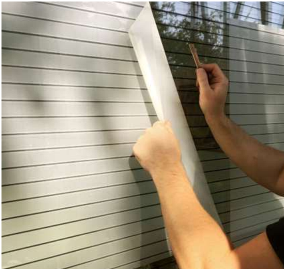
Bei der Aufbringung ausgeplotteter Folienmuster werden nur die Musterelemente selbst verklebt.
